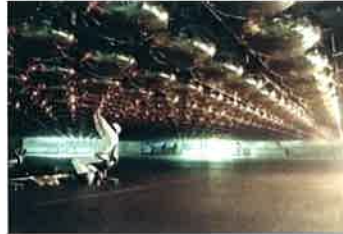
写真8. 天井PMTの 取り付け
