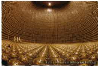
写真2. 内部 (PMT設置後)
