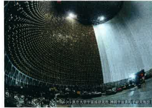
写真9. 側面PMT設置工事
