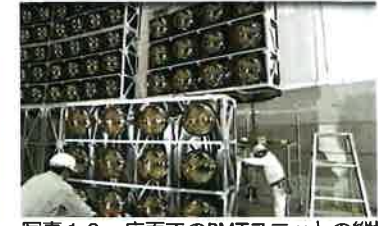
写真10. 床面でのPMTユニットの縦接続
