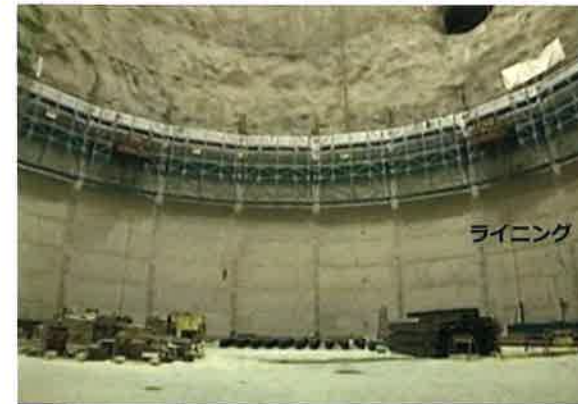
写真3. ライニング工事
